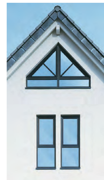
A vízszintesen elhelyezkedő osztóbordák a vízszintes síkot hangsúlyozzák, és növelik a szélesség érzetét.
